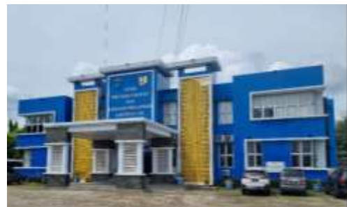
Gambar 2. Façade bangunan Gedung, Dinas Perumahan Rakyat dan Kawasan Permukiman, Kab. OKI, Sumatera Selatan, menggunakan secondary skin ACP metal, sebagian masif dan sebagian cutting laser berpori. Sumber: Penulis, 2022.
