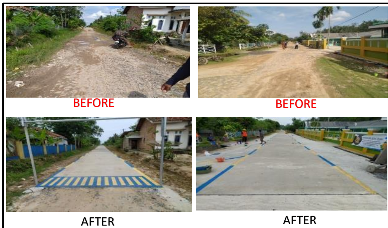
Gambar 12. Sebelum dan Sesudah Pembangunan Jalan Rabat Beton
